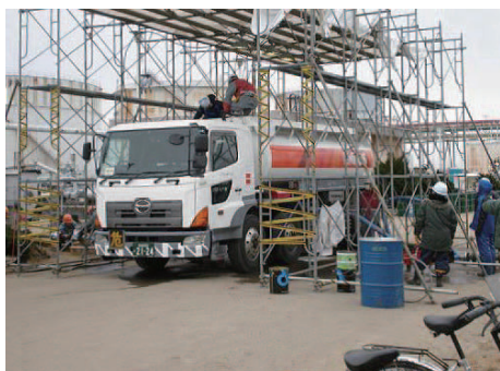
屋外タンクから移動タンク貯蔵所に危険物を移し替えている様子 (仙台市消防局提供)
